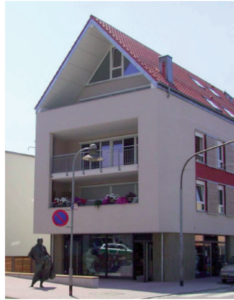
Gliederung EG zu OG mit Sichtbeton Gebäude Bahnhofstraße
