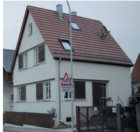
Satellitenschüssel in Dachfarbe
