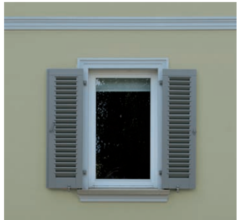
Nachträglicher Wärmedämmputz Lindenstraße
