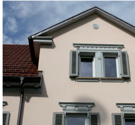
Nachträglicher Vollwärmeschutz mit sanierten historischen Gestaltungselementen und Dachdetails
