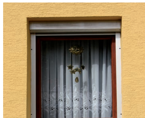
außenliegender Rollladenkasten hinter Fassadenflucht bleibend
