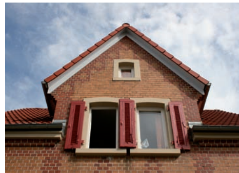
Sichtmauerwerk Gebäude in der Christofstraße
