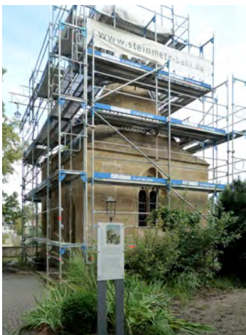
1 | denkmalgerechte Sanierung der Regiswindiskapelle
