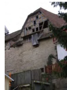
Ansicht von der Stadtmauer
