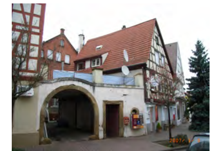
Seitliche Hofmauer mit Einfahrt
