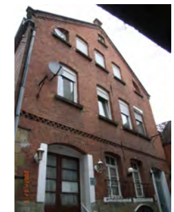
Hinterhaus Lange Straße 10/1
