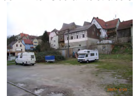
Vorstadtmauer bei Heilbronner Str. 7
