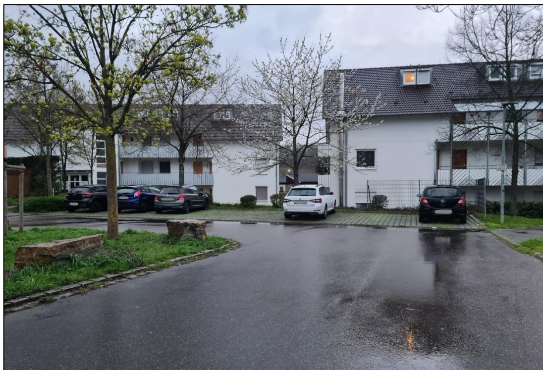
Abbildung 05: Wendeanlage Ginsterweg (2) Quelle: Aufnahme BS Ingenieure, März 2023
