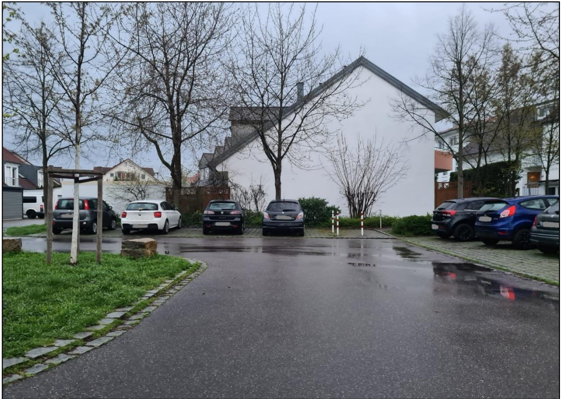
Abbildung 06: Wendeanlage Ginsterweg (3) Quelle: Aufnahme BS Ingenieure, März 2023
