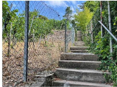
Treppenanlage zwischen Werderstraße und Mühltorstraße
