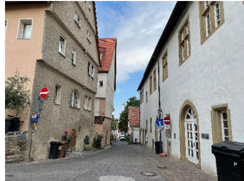
Bereich Heilbronner Straße mit Alter Kelter und Heilbronner Straße 44 (beide § 2 DSchG)
