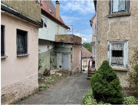
Heilbronner Straße 11 (§ 2 DSchG), 15 (erhaltenswert), 17 (erhaltenswert)
