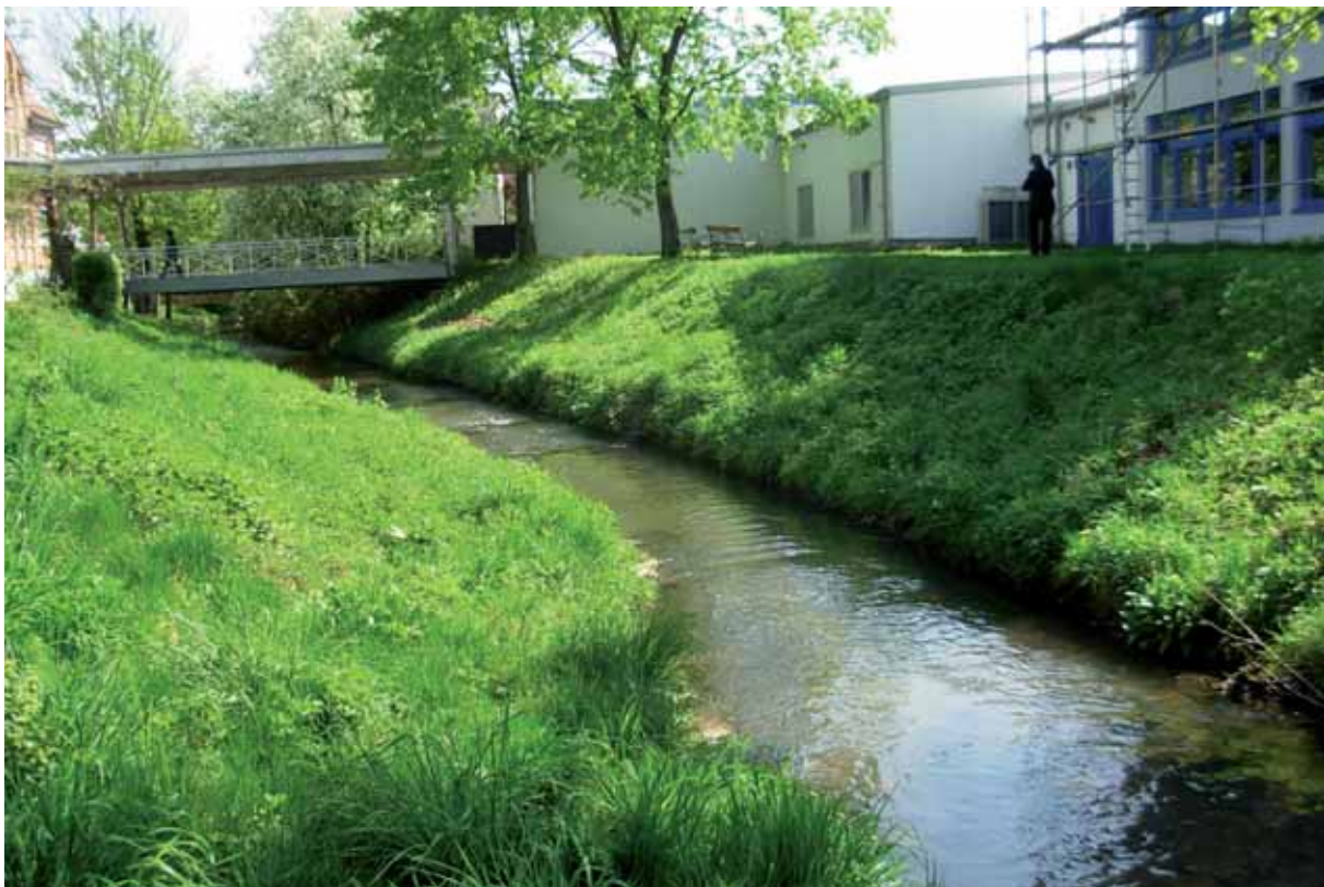
Bild 5.15: Zaber Abschnitt 15 – zwischen km 13+200 und km 13+300
