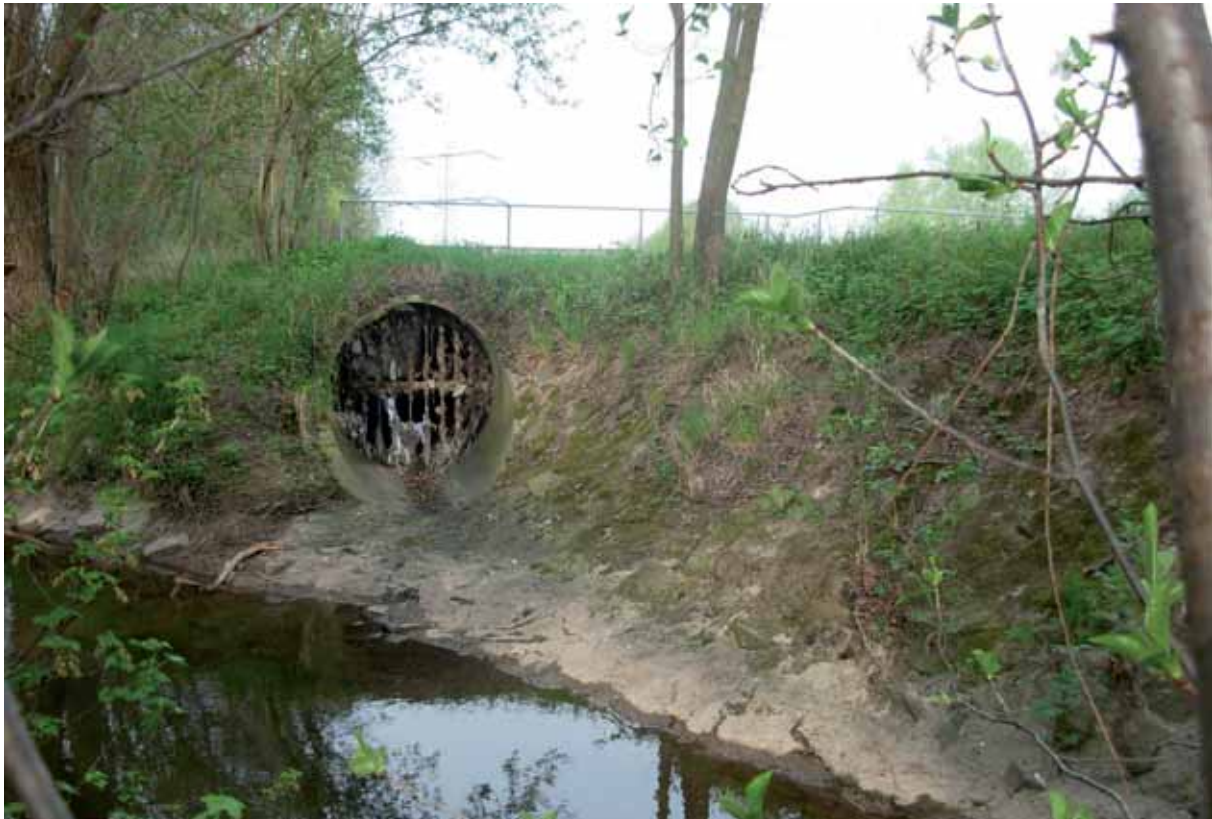
Bild 5.14: Zaber Abschnitt 14 – zwischen km 10+000 und km 10+100
