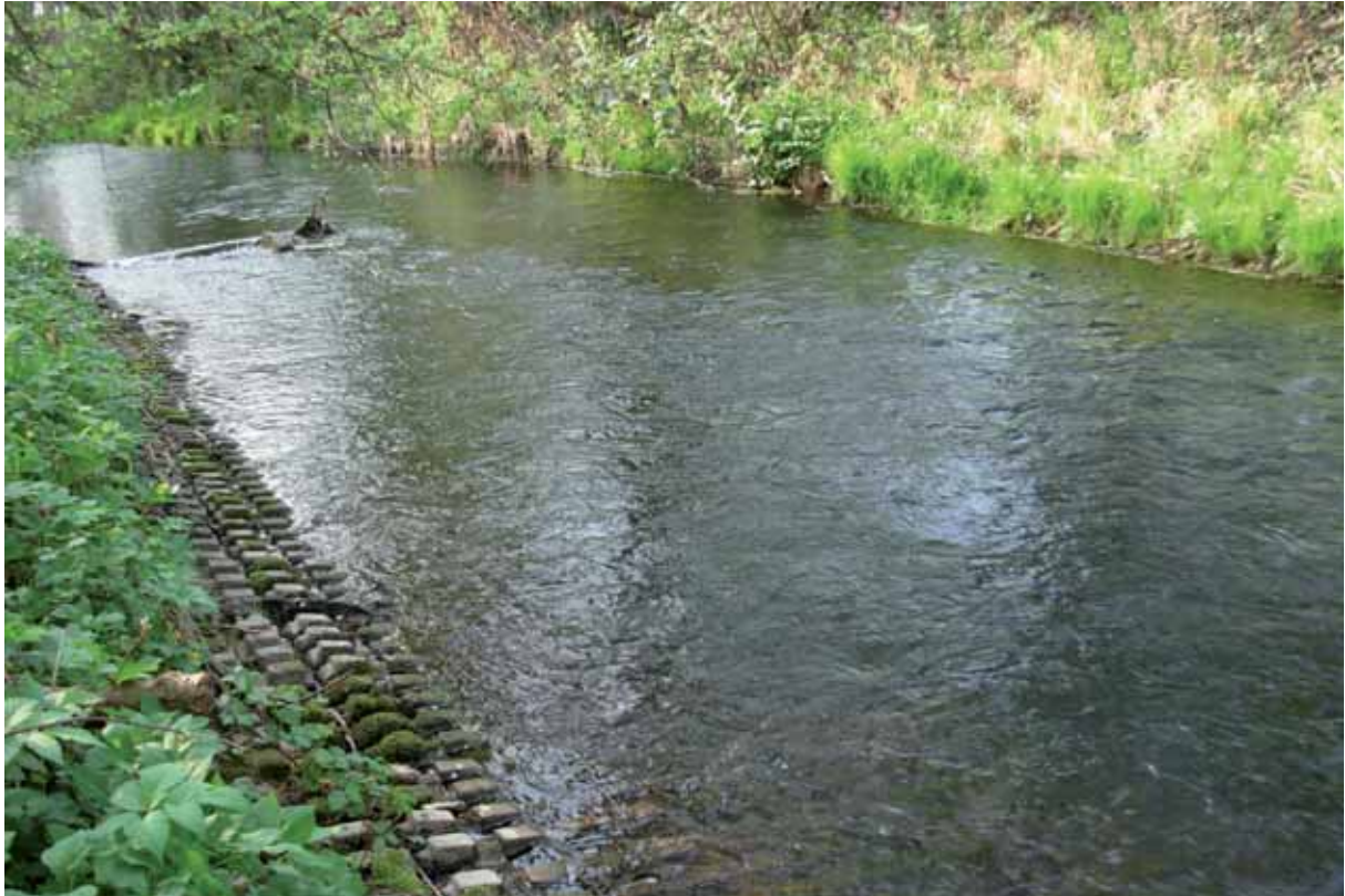
Bild 5.6: Zaber Abschnitt 6 – zwischen km 3+600 und km 3+700
