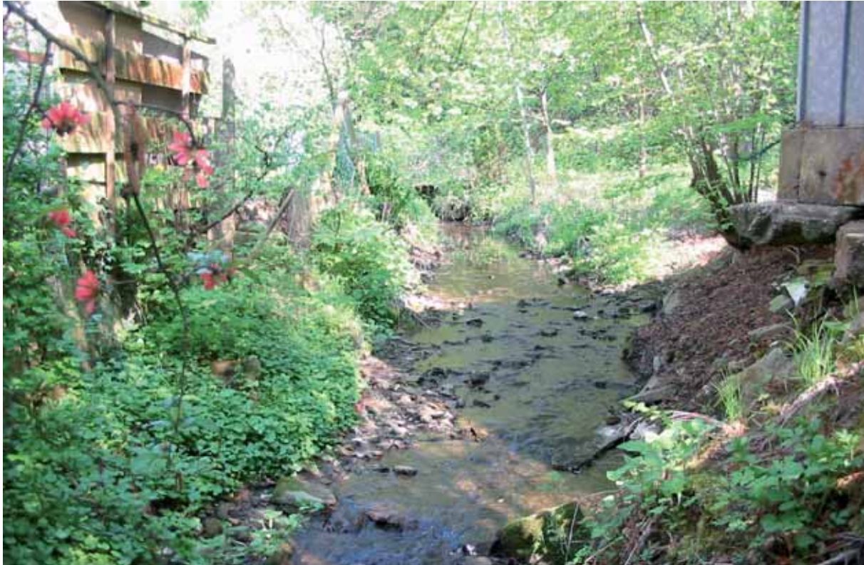
Bild 5.23: Riesenbach Abschnitt 3 – zwischen km 1 + 500 und km 1 + 600
