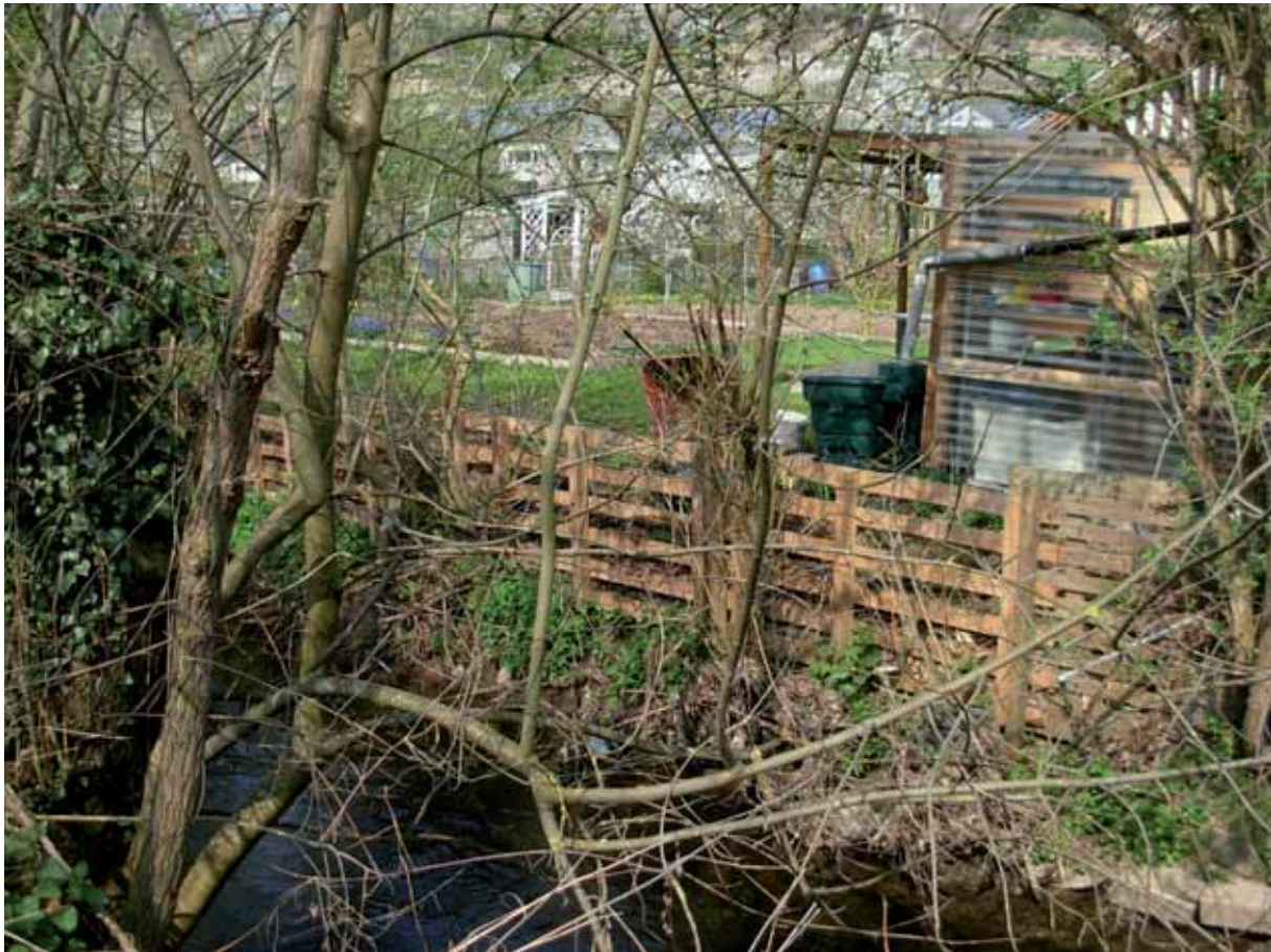
Bild 5.2: Zaber Abschnitt 2 – privater Uferverbau bei km 0+800 bis 0+900
