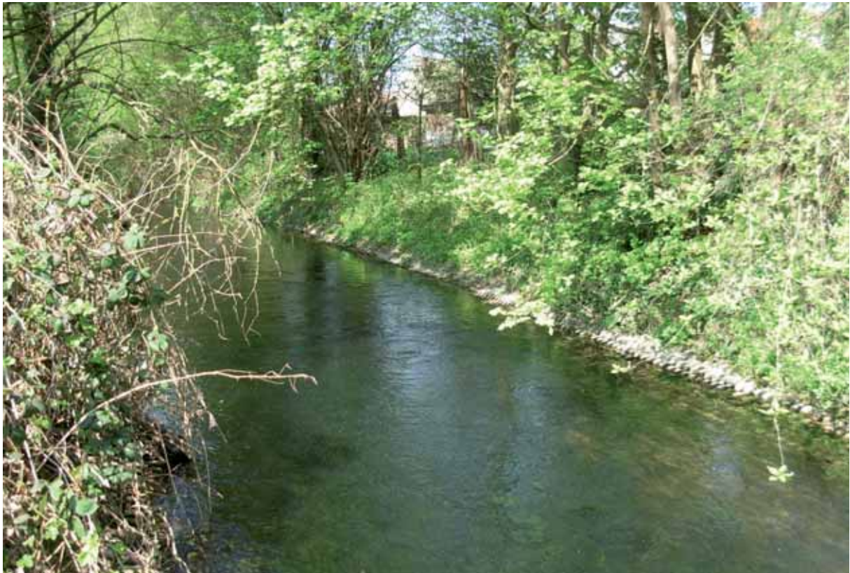
Bild 5.10: Zaber Abschnitt 10 – zwischen km 6+100 und km 6+200
