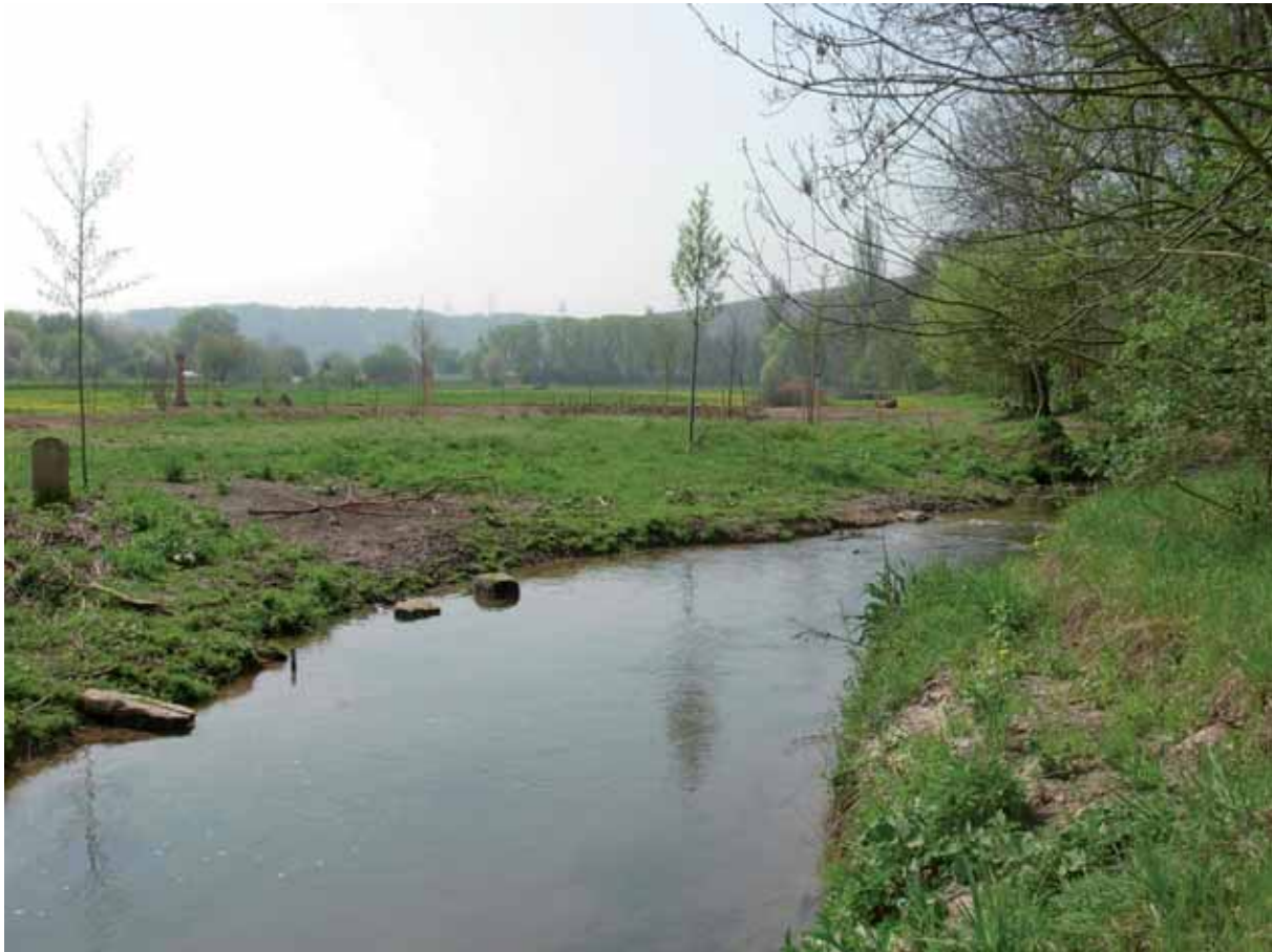
Bild 5.3: Zaber Abschnitt 3 – umgestalteter Abschnitt zwischen km 1 + 400 und km 1 + 500
