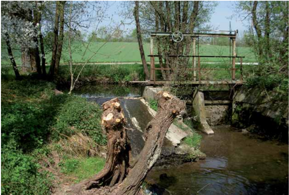
Bild 5.12: Zaber Abschnitt 12 – zwischen km 7+600 und km 7+700
