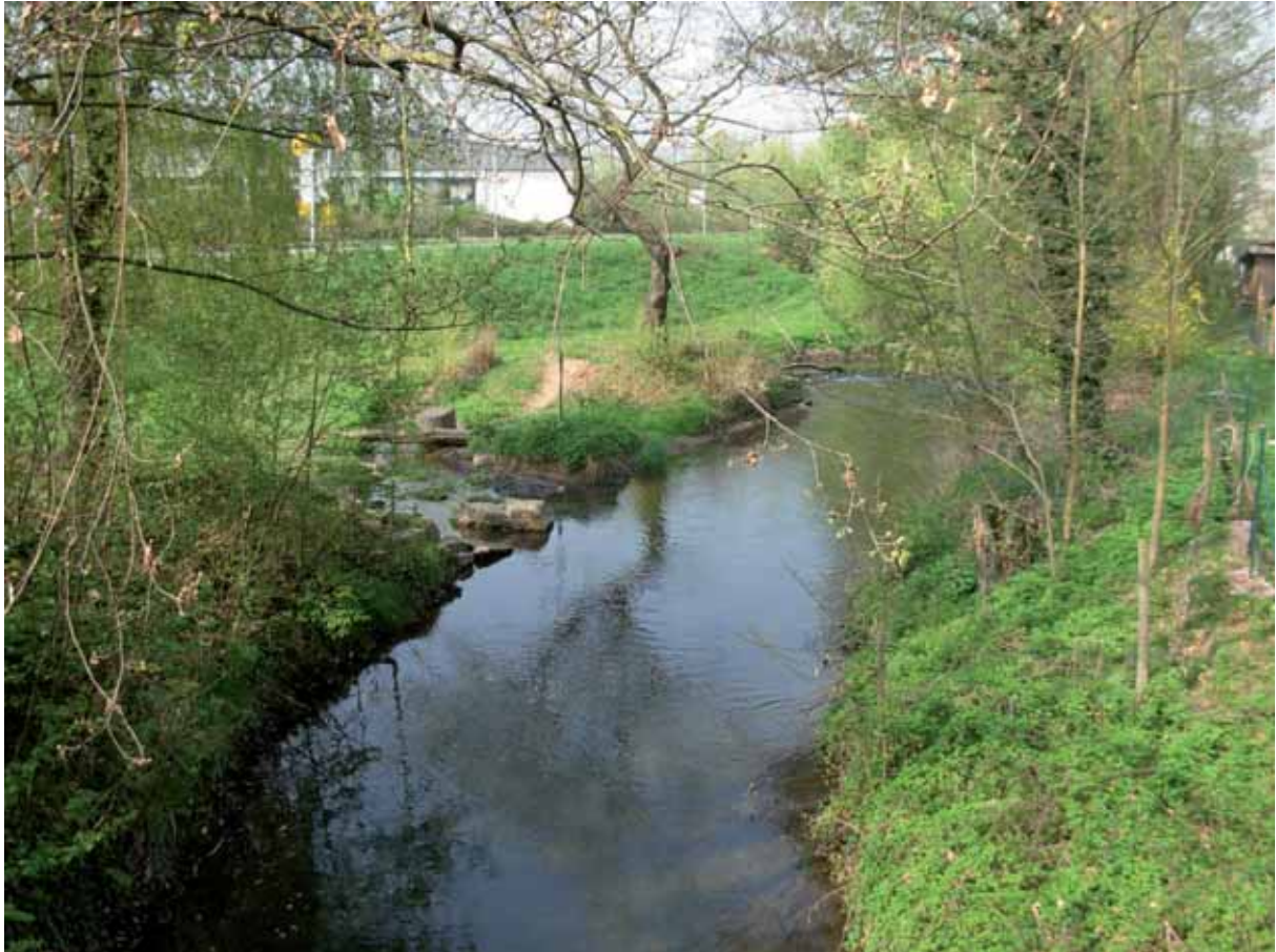
Bild 5.1: Zaber Abschnitt 1 - umgestalteter Abschnitt bei km 0+475
