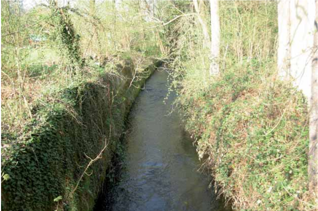
Bild 5.8: Zaber Abschnitt 8 – zwischen km 4+700 und km 4+800
