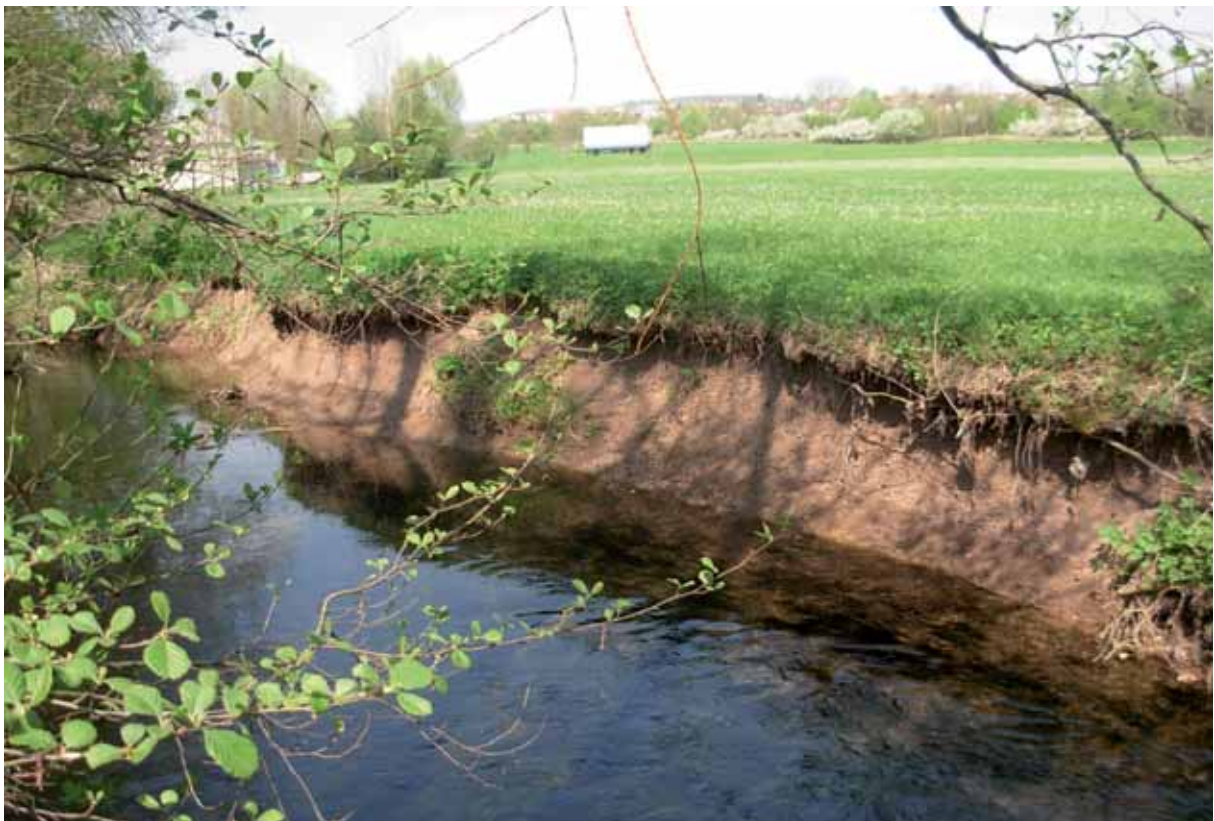
Bild 5.11: Zaber Abschnitt 11 – zwischen km 7+300 und km 7+400
