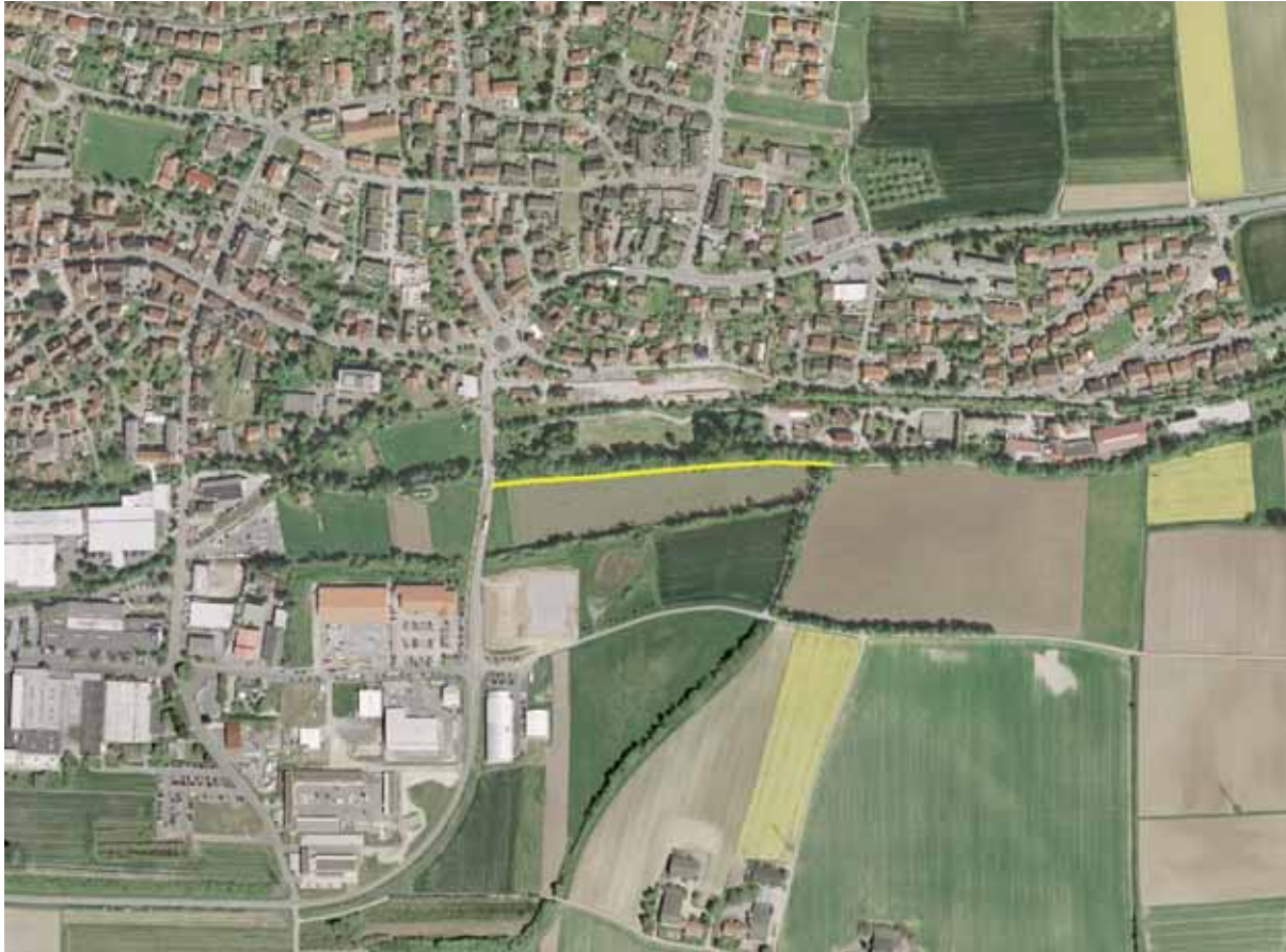
Abbildung 7.6: Ausbau eines vorhandenen Feldweges zur Optimierung der Fußwegesituation in Güglingen.
