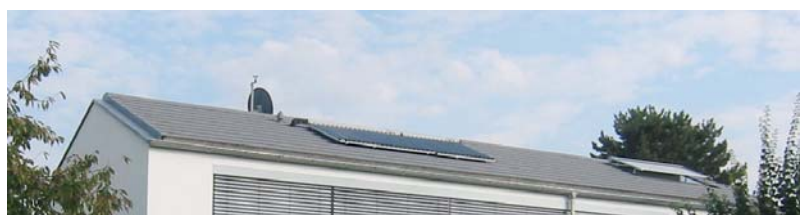
Abb. 4.1 Gelungene Dachausbildung: knapper Dachrand, Sonnenkollektoren und Dachfenster sind hervorragend und unaufdringlich in die Fläche integriert.
