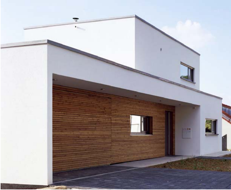
Abb. 4.4 Integration von Garage, Hauseingang und Vordach. Auch der Briefkasten ist überlegt.
