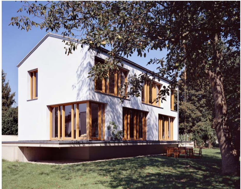
Abb. 8.1 Zurückhaltende Putzfarbe, Gebäude erhält Freundlichkeit durch angenehme und prägnante Holzfenster; Fenster sind zusammengesetzt aus "stehenden" Formaten, versetzte Fensterfelder machen das Gebäude lebendig.
