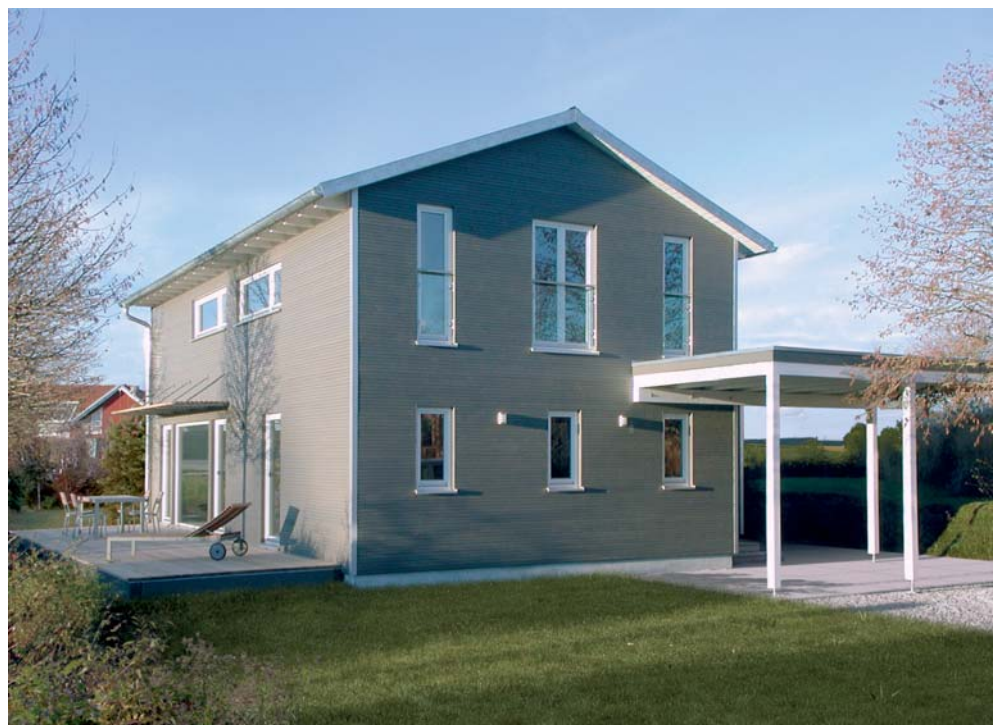
Abb. 8.13 Gebäude mit Satteldach und Holzverschalung. Ein kleines Vordach gliedert den Zugangsbereich.
