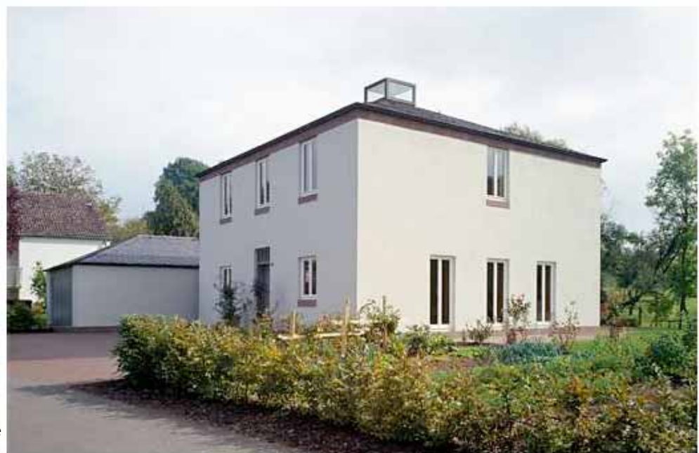
Abb. 8.17 Flach geneigtes Zeltdach mit Dachlaterne, schmale und hohe Fenster. Qualität wird erzeugt durch feine Detailausbildung.
