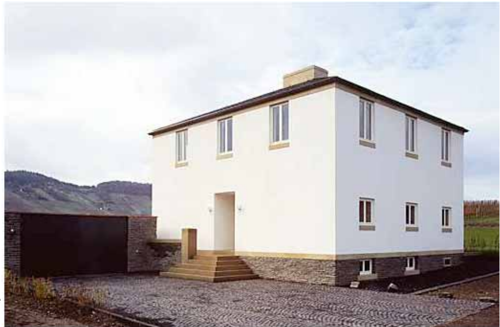
Abb. 8.16 Flach geneigtes Zeltdach (als Sonderform des Walmdaches), zurückhaltende Putzfarbe, geordnete Fenster und eine feine Detailausbildung erzeugen eine hohe gestalterische Qualität.
