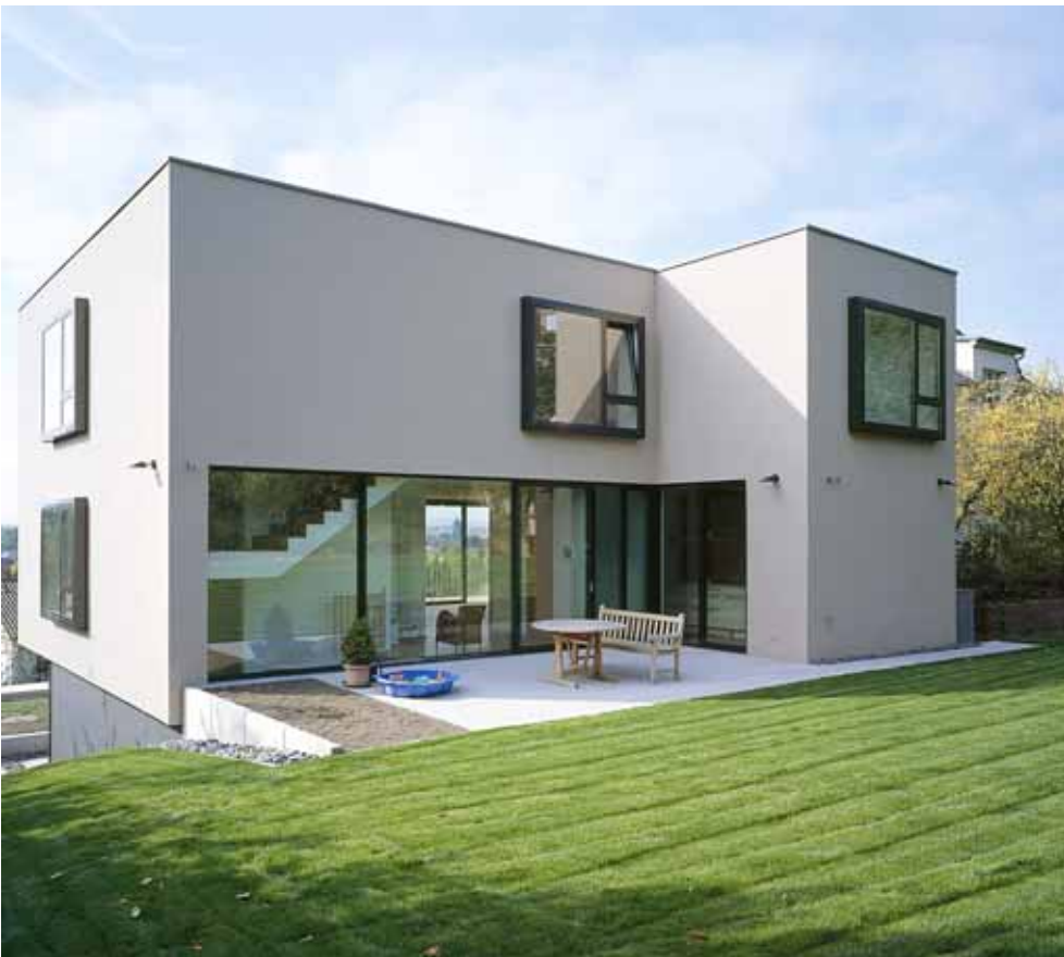
Abb. 8.18 Angenehmer Sitzbereich durch Winkelform des Gebäudes. Kastenfenster und große Verglasung im EG wechseln sich mit geschlossenen Wandbereichen ab.
