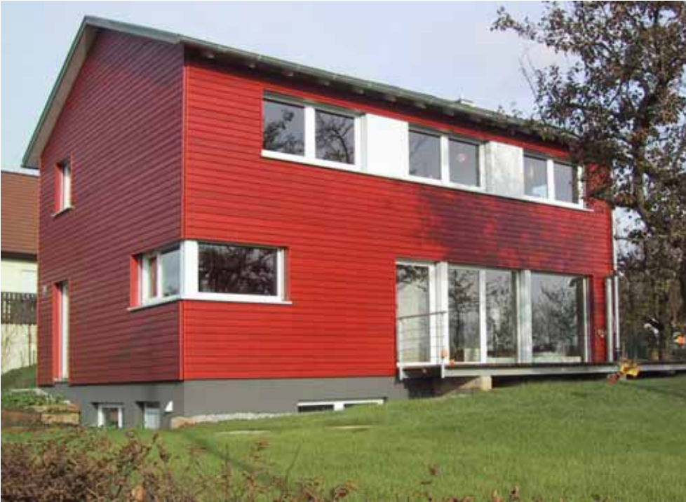
Abb. 8.3 Gebäude mit Satteldach und Holzverschalung.
