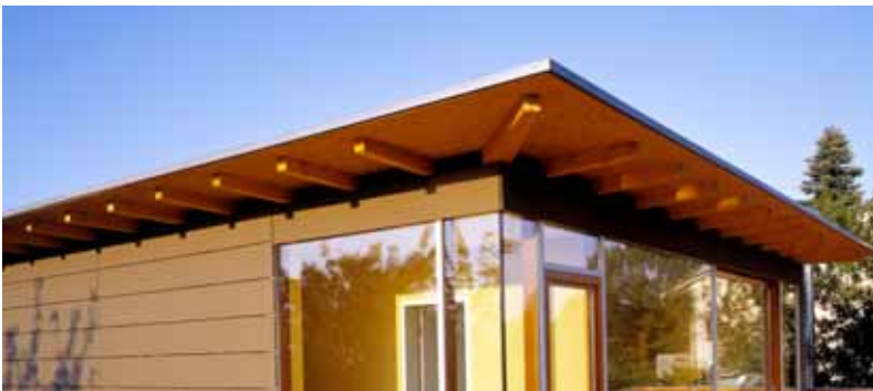
Abb. 4.2 Weit auskragendes Dach mit überlegter Detailausbildung
