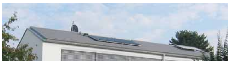
Abb. 4.1 Gelungene Dachausbildung: knapper Dachrand, Sonnenkollektoren und Dachfenster sind hervorragend und unaufdringlich in die Fläche integriert.
