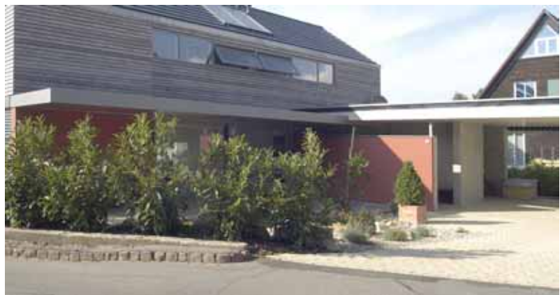
Abb. 4.3 Integration von Vordach, Stellplatz, Zufahrt und Zugang. Fein abgestimmte Differenzierung von öffentlichen und privaten Bereichen
