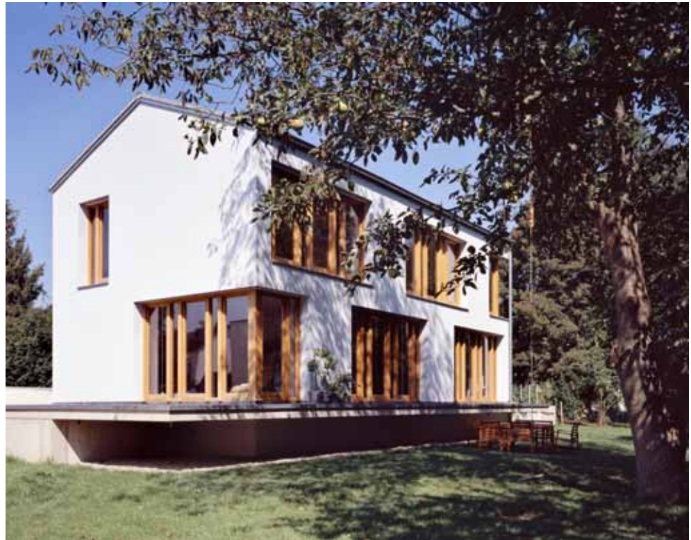
Abb. 8.1 Zurückhaltende Putzfarbe, Gebäude erhält Freundlichkeit durch angenehme und prägnante Holzfenster; Fenster sind zusammengesetzt aus "stehenden" Formaten, versetzte Fensterfelder machen das Gebäude lebendig.
