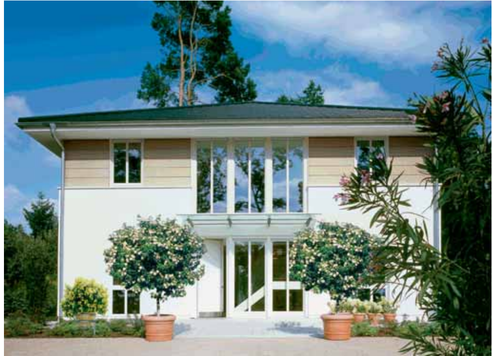
Abb. 8.19 Flach geneigtes Zeltdach und abgesetzte Fensterzone im OG harmonisieren mit einander.
