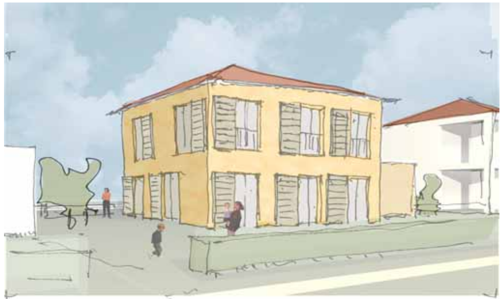
Das Punkthaus mit Putzfassade und Schiebeläden, von Südwesten (Ortsrand) aus gesehen.
