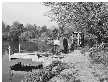
Das Team vom Bauhof bei der Begutachtung der ausgespülten Schiffsanlegestelle am Kiesplatz. (Foto: Bauhof)
