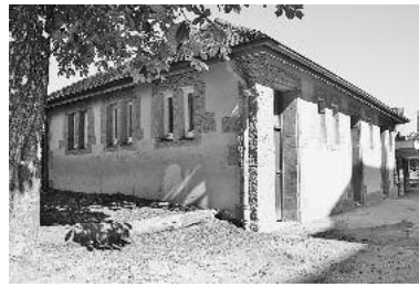
Das ehemalige WC-Gebäude soll zu einem Mehrzweckraum umgebaut werden.
