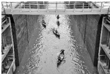
8,40 m tiefer beeindruckt die Schleusenkammer besonders
