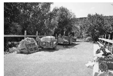
Die Arbeiten liegen im Zeitplan, so dass ab September die Zaberbrücke wieder befahrbar sein wird. Foto: Haar
