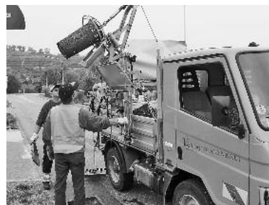
Mit dem Sinkkastenreiniger werden die Schächte gereinigt. (Foto: Brück)
