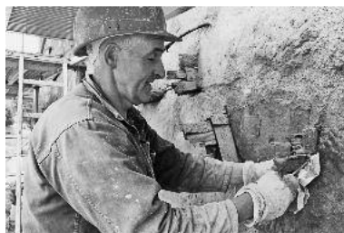
Paul Helfrich von der Firma Renovum schlug vor der Verfüllung der Mauer Hölzer in Wandöffnungen um Rückzugsräume und Nistgelegenheiten z. B. für Fledermäuse und Maueregler zu schaffen. (Foto: Thumm)
