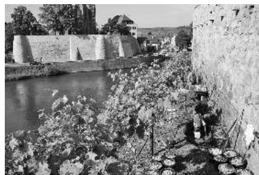
Insgesamt werden durch den Bauhof mit Steinen unterschiedlicher Größe vier neue Lebensräume für Mauereidechsen rund um die Burgmauer geschaffen. (Foto: Ehle)
