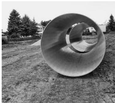
GFK-Rohrelement des Regenwasserstaukanals mit 2,5 m Durchmesser
