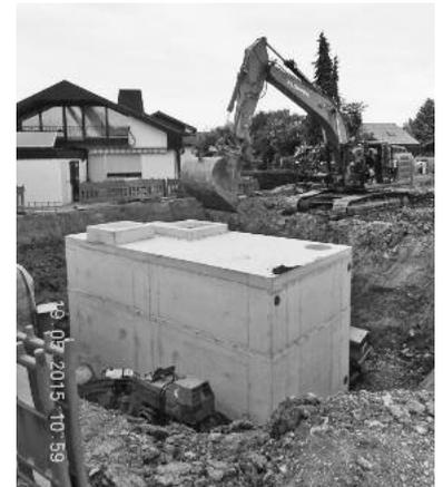
Drosselschacht des Staukanals als Fertigteil mit ca. 70 t Gesamtgewicht
