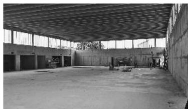
Die Rohbauarbeiten zur Erstellung der Dreifeldsporthalle mit Betreuungszentrum kommen gut voran und liegen im vorgegebenen Zeitplan. Bis Ende April wurden die aufgehenden Wände der Sporthalle bis Unterkante Decke betoniert und Mitte Mai wurden die Deckenplatten montiert. Das Betreuungszentrum folgt mit einem Abstand von 4 – 6 Wochen dem Arbeitsrhythmus der Sporthalle nach. Zur termingerechten Weiterführung der Arbeiten wurde ein viertes Ausschreibungspaket aufgelegt. Die Gewerke wur-
