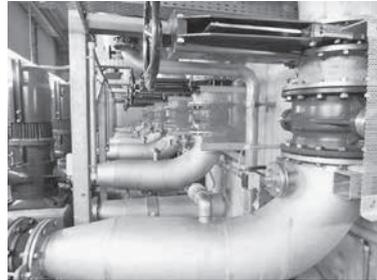
In Vorlage Nr. 22/2016 wurde im Maßnahmenblock 3 (Verfahrenstechnische und energetische Optimierung der Tropfkörperpumpen) die Neuanschaffung der Tropfkörperpumpen beschrieben. Die 2015 durchgeführte Überprüfung der Pumpen bestätigt den deutlichen Pumpenverschleiß an den 16 Jahre alten Pumpen (Ausnahme: neueste Pumpe P1, DN-Tropfkörper).
