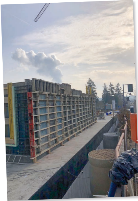
Im Erdgeschoss des Gebäudes entsteht die Tages- pflege für Senioren.
