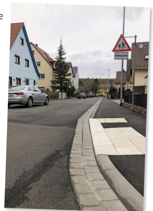
Die Herdegenstrasse wurde mit Behindertenleitsystem ausgebaut.
