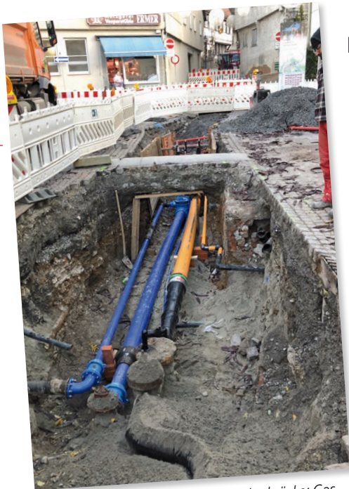
Von der B 27 Brücke in die Alte Neckarbrücke: Gas und Wasser für das „Dorf“
