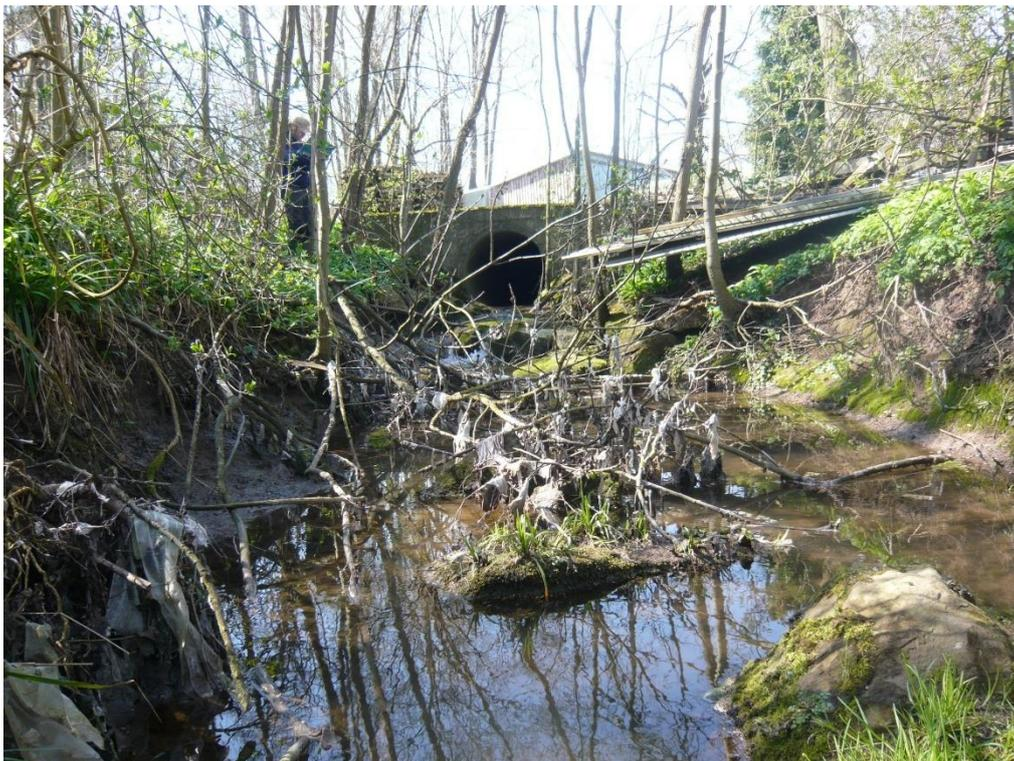
Abbildung 36: Flügelaub am Dolenende in Güglingen-Eibensbach, unterhalb von RÜB E13 (Einleitung 54) am 25.03.2020. Kanalisationsrückstände und Erosion zeigen vergangene Entlastungsereignisse an.
