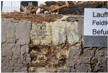
An dem in situ verbliebenen Teil des Traufgesimses sind vier Fassungen nachzuweisen. Der älteste Anstrich besteht aus einer grauen Ölfarbschicht. Es folgen eine gelblich helle und zwei graue Fassungen. Der Fassungbestand ist insgesamt stark reduziert.
