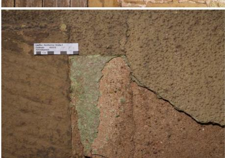
Zur Flächenverputzung des Erdgeschosses gehört ein vorspringender Putzsockel mit einer Besenwurfstruktur und glatt gezogener Oberkante. Die älteste Sichtfassung ist eine grün gefärbte Schlämmverputzung, die wohl aus der ersten Hälfte des 20. Jahrhunderts stammt. Dieser Bestand wurde in den 1950/60er Jahren überputzt und zwei Mal gestrichen. Putz- und Fassungsbestand aus den vorangegangenen Jahrhunderten ist den Sondierungen zufolge nicht erhalten.
