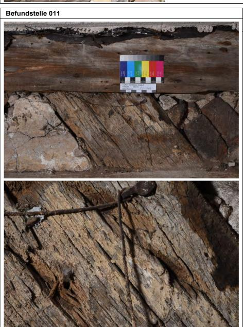
Auf den Holzoberflächen des Fachwerks sind helle Tünchen nachzuweisen. Nachträglich wurden die Holzoberfläche angebeilt und Nägel für die Armierung mit Draht eingeschlagen.
