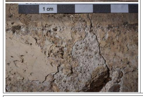
Die gemauerte Ausfachung ist mit einem einschichtigen Putz überzogen. Der Putz schließt bündig an die Fachwerkhölzer an. Die Putzoberfläche wurde mehrfach hell getüncht. Die Tünchen sind altersbedingt vergilbt und verschmutzt.
