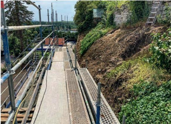
Der in den Nachkriegsjahren eingestürzte mittlere Mauerabschnitt wird wiederaufgebaut
