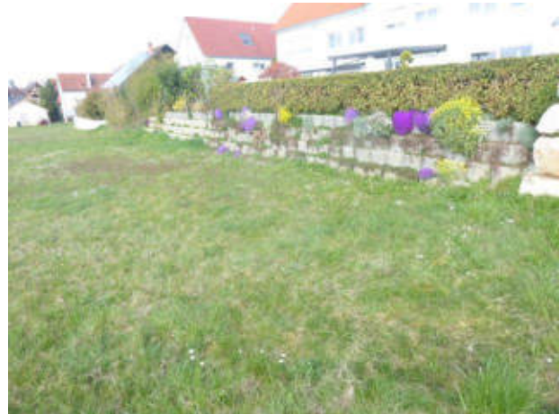
Abb. 12: Mauerabschnitt mit Betonpflanzsteinen nördlich von Flst.-Nr. 288.
