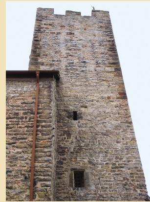
Links: der von den Markgrafen von Baden nach 1219 erhöhte Bereich des Turmes setzt sich deutlich sichtbar durch seine Eckquader vom älteren Mauerwerk ab.
