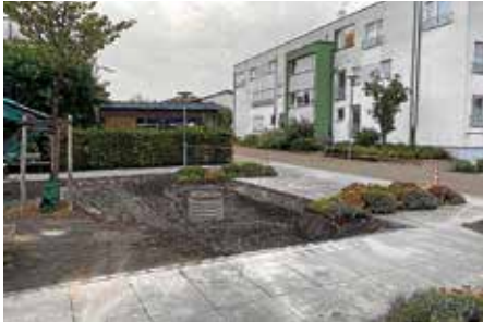
Umbau Quartiersplatz Schillerstraße Foto: Helge Spieth
