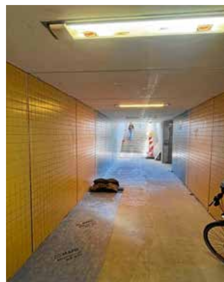
Mittlerweile wurde die Unterführung und der Zugang zu den Zügen im Auftrag der Deutschen Bahn gefliert.
