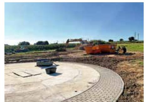
Die fertiggestellte Bodenplatte für den Neubau des Faulturns.
