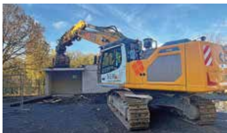
Das alte Pumpwerk wurde abgerissen.
