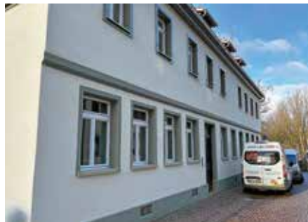
Die Alte Apotheke wird derzeit aufwändig saniert – Lob gab es dafür letzte Woche vom Landesdenkmalamt
