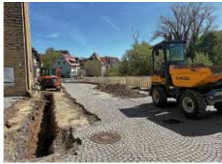
Baggerarbeiten im Rathaushof auf der Insel
