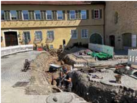
In den vergangenen Wochen fanden die Leitungsverlegungen im Burghof zur Vorbereitung auf den Neubau der Rathausbrücke statt.
