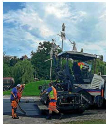
Ortsdurchfahrt in nur einem Monat komplett erneuert
