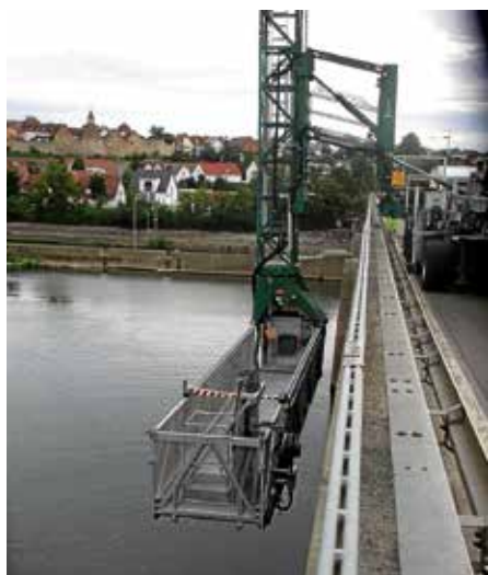
Schwierige Konservierungs- und Instandsetzungsarbeiten mit Untersichtgerät an Schleusenbrücke B27
