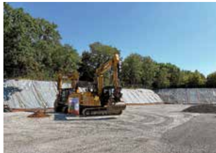
59 öffentlich geförderte Wohnungen baut die GEWO auf diesem Grundstück
