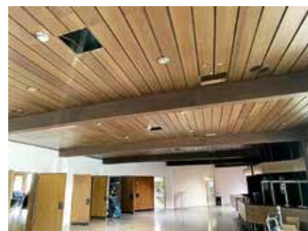
In der Stadthalle wurden umfangreiche Sanierungs- und Instandhaltungsmaßnahmen an der Lüftungsanlage durchgeführt
