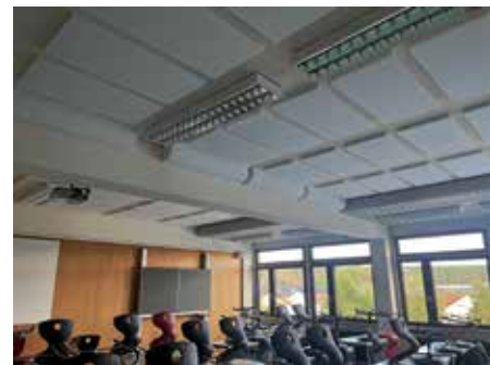
Im Hölderlin-Gymnasium erhielten weitere Klassenräume eine schallschutztechnische Verbesserung
