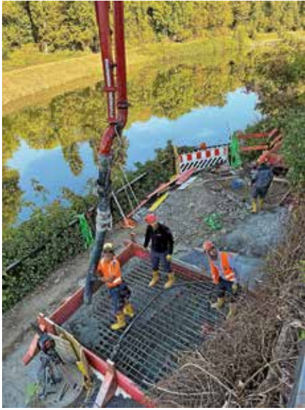
Am Samstag wurde der Aufbau des Autokrans vorbereitet
