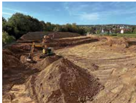
Gigantische Erdmassen werden in der Mühltorstraße bewegt
