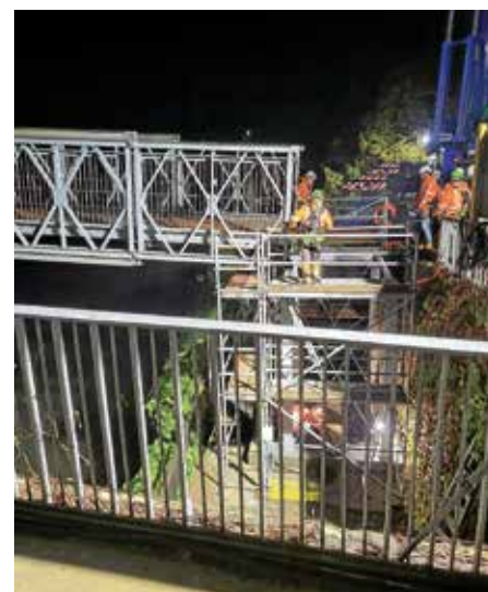
Nachtschicht bei der Insel: unsere Behelfsbrücke kommt
