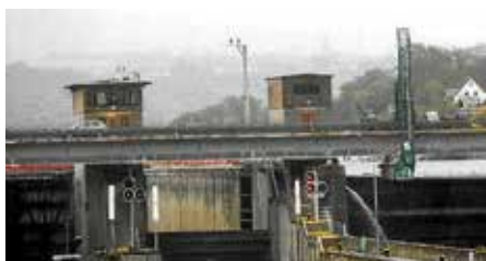
B 27 Schleusenbrücken-Sanierung: Auf der rechten Seite sieht man das Brückenuntersichtgerät, das die Brücke nach Schäden abfährt.
