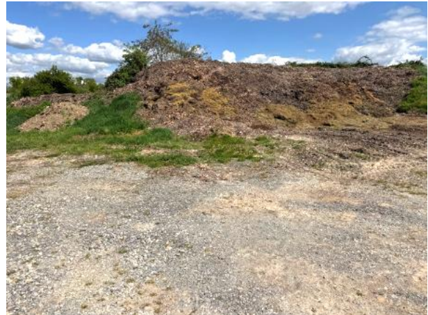
Abb. 9: Blick auf die Böschung aus Westen mit frisch bewegtem Erdmaterial und Kompost.
