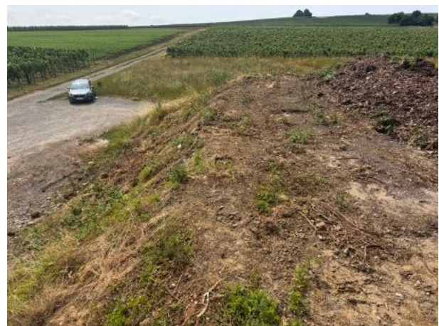
Abb. 7: Blick auf die Böschung mit frisch bewegter Erde am 18.07.2026.
