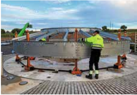
Der Bau des Faulbehälters für 3 Mio. Euro auf der Kläranlage ist gestartet
