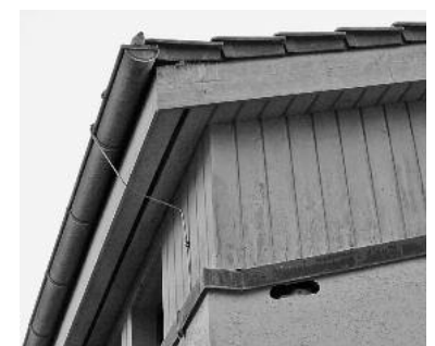
Ein Spechthoch an der Fassade des Gebäudes auf der Sportanlage Ulrichsheide.
