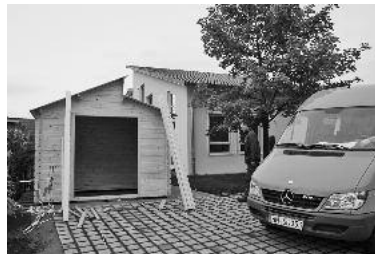
Die Hütte ist beinahe fertig, es muss nur noch eine zweite Türe eingebaut werden.
